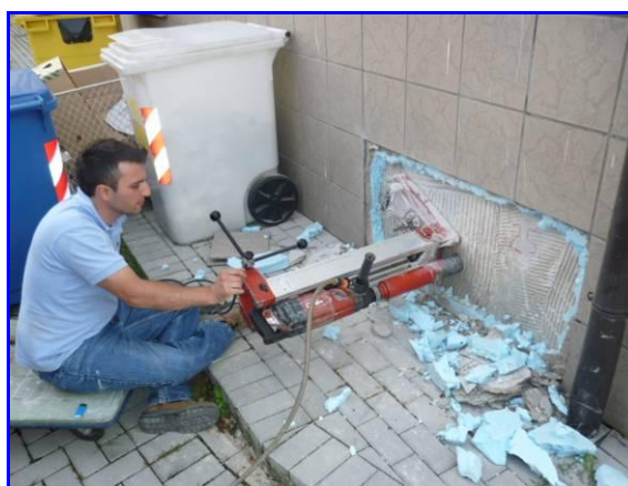
Foto 4: Carotaggio su pilastro
