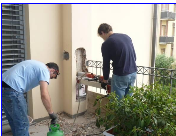
Foto 3: Carotaggio su pilastro
